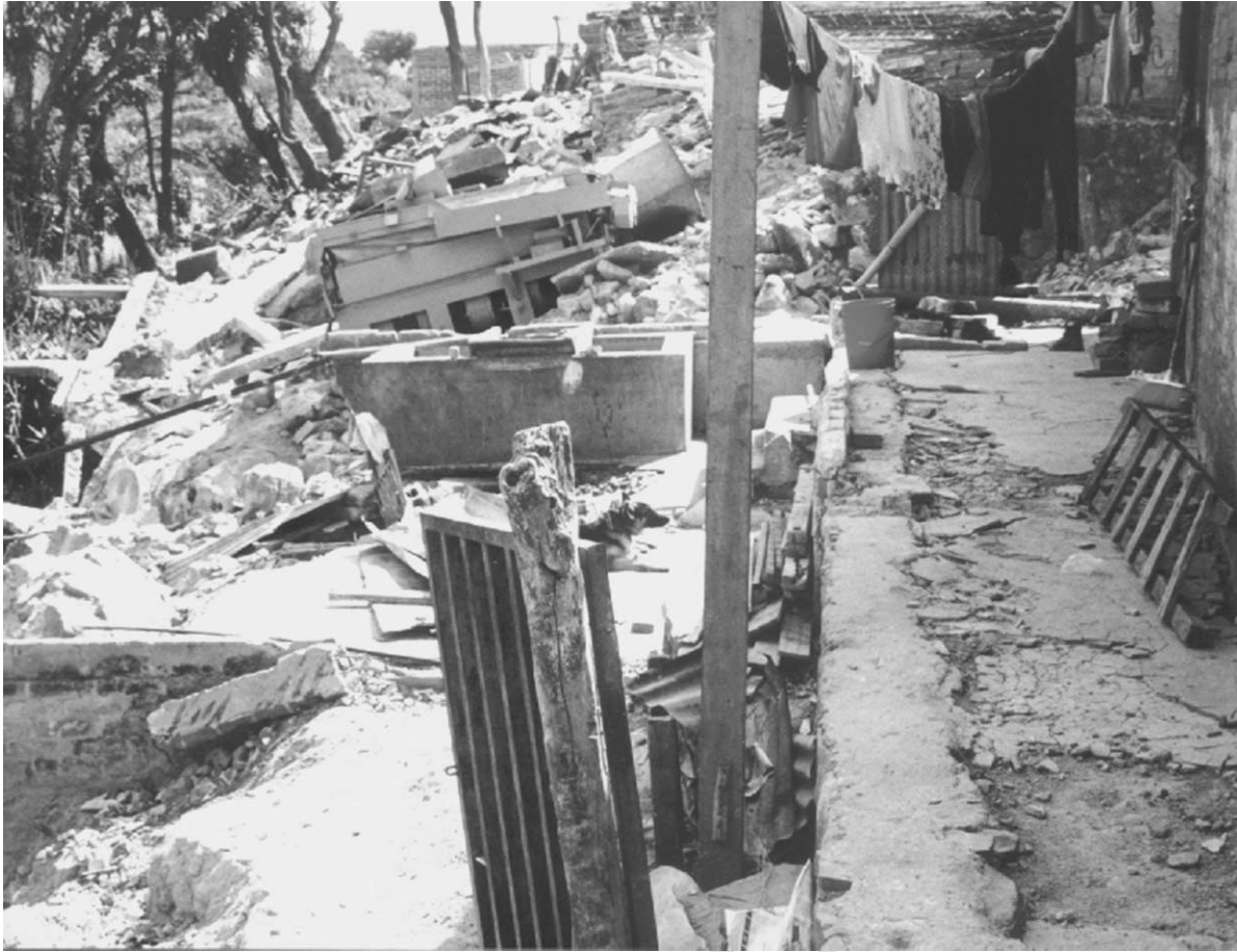
Fig. 16. Landslide damage in Comasagua.
