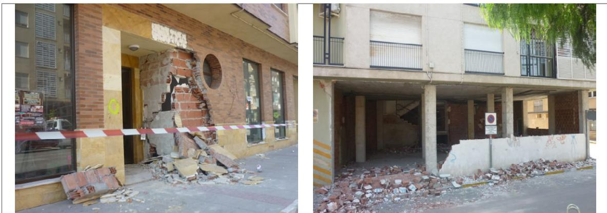
*Figura 5.13* Daño en los edificios en planta baja tras el terremoto de Lorca de 2011
