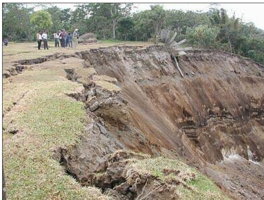
Figura 10.5. Vista de la parte superior del escarpe donde se inició el Deslizamiento Las Colinas (Santa Tecla, 13-01-2001, USGS)
