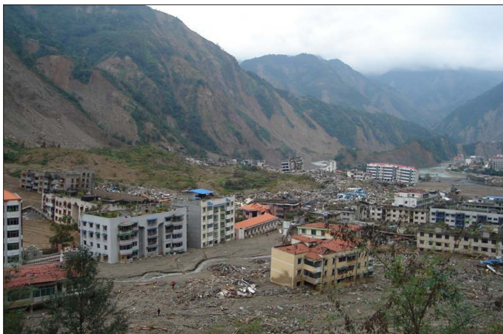
Figura 3.5. Vista panorámica de la destrucción de viviendas y de los deslizamientos inducidos tras la ocurrencia del terremoto el 12 mayo de 2008 en Beichuan (Sichuan, al SO de China). (Fuente: P. Murphy)
